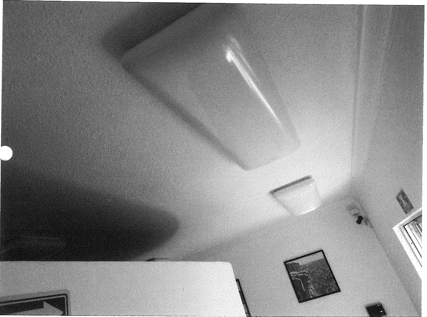
LAMPARAS EN PASILLO DE ENTRADA DEL ESTACIONAMIENTO
