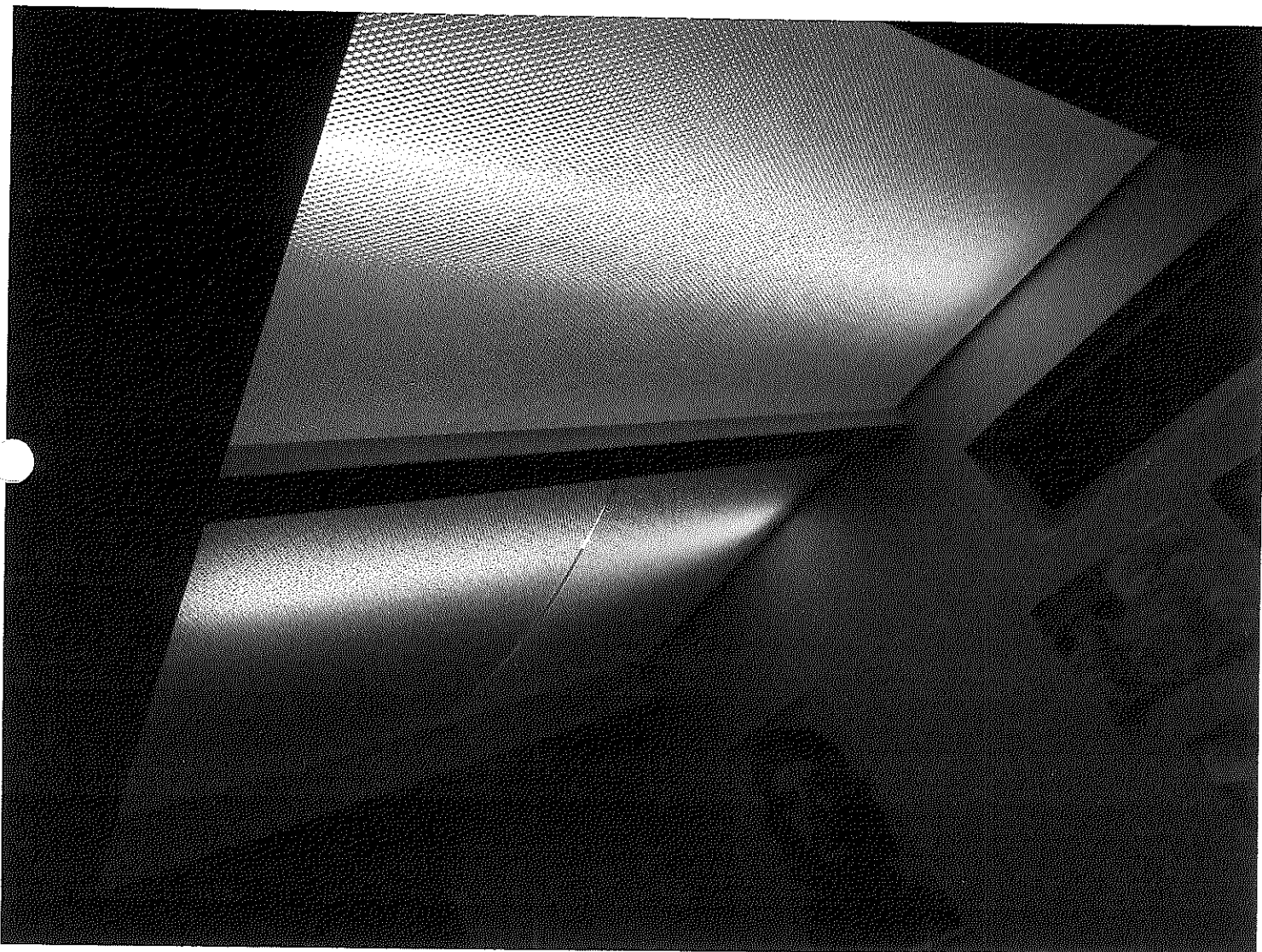
MAL ESTADO DE LOS ACRILICOS DE LAS LAMPARAS DEL PRIVADO DEL LICENCIAD CARLOS GUTIERREZ CASAS
